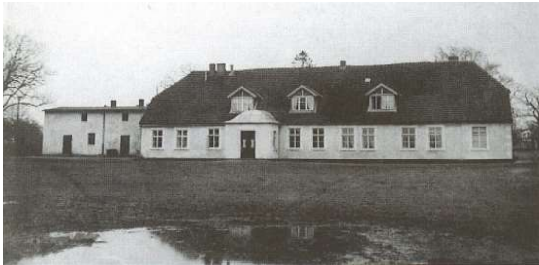
Inspektorenhaus auf dem Sandhof
